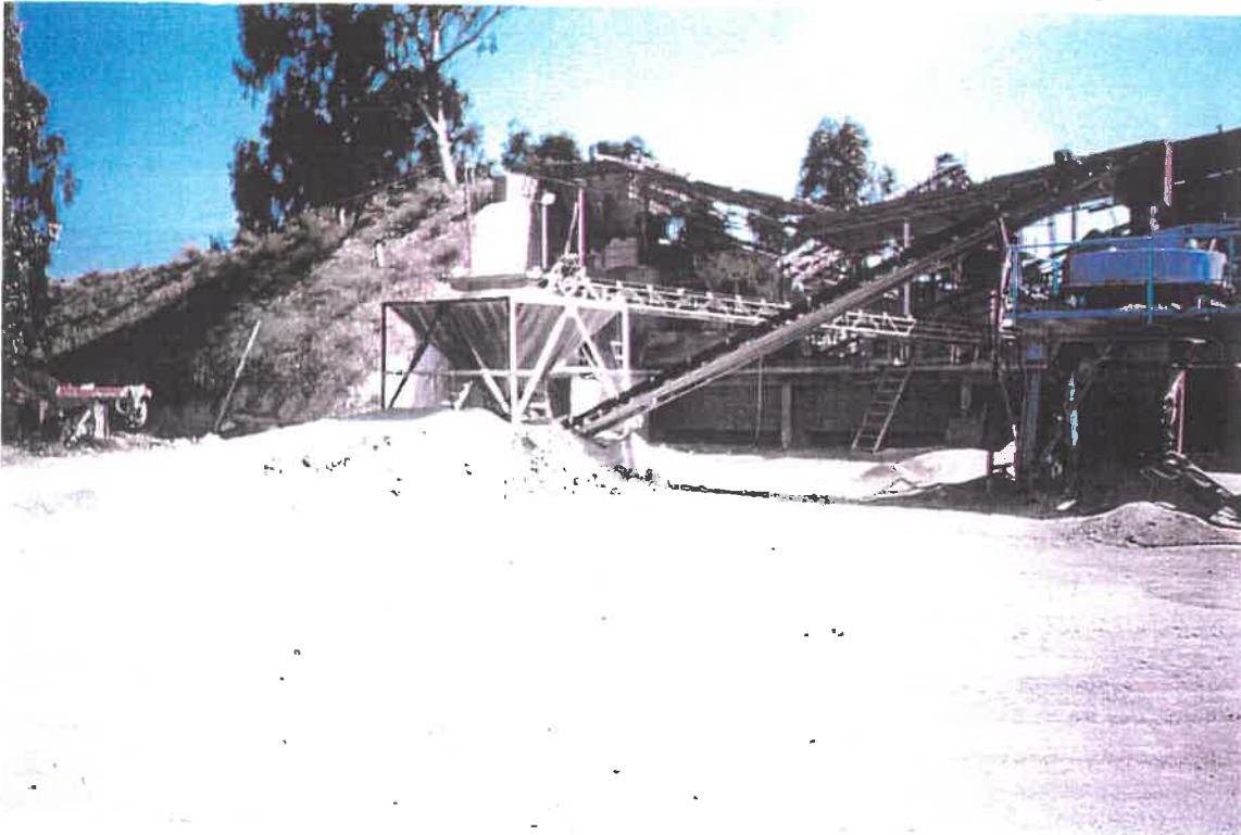
Εικ. 6.13: Γενική άποψη συγκροτήματος σπαστηροτριβείου
