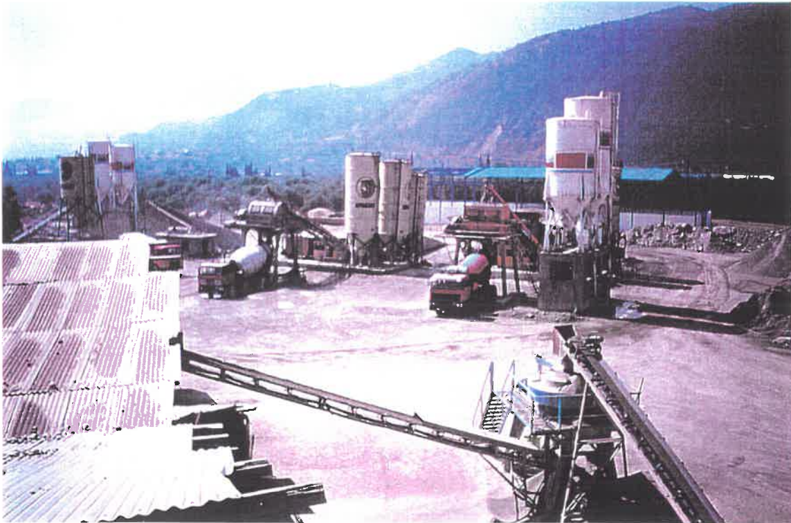
Εικ. 6.1: Άποψη του εργοστασίου σκυροδέματος στο οποίο πραγματοποιήθηκε η διπλωματική εργασία
