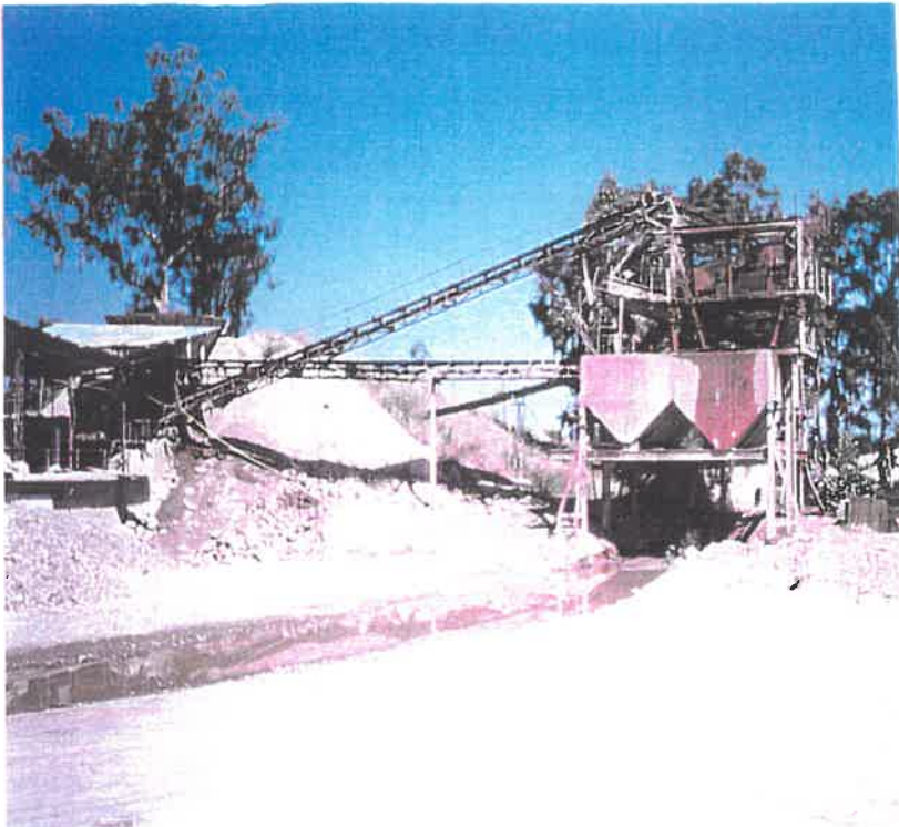
Εικ. 6.10: Άποψη πλυντηρίου αδρανών υλικών
