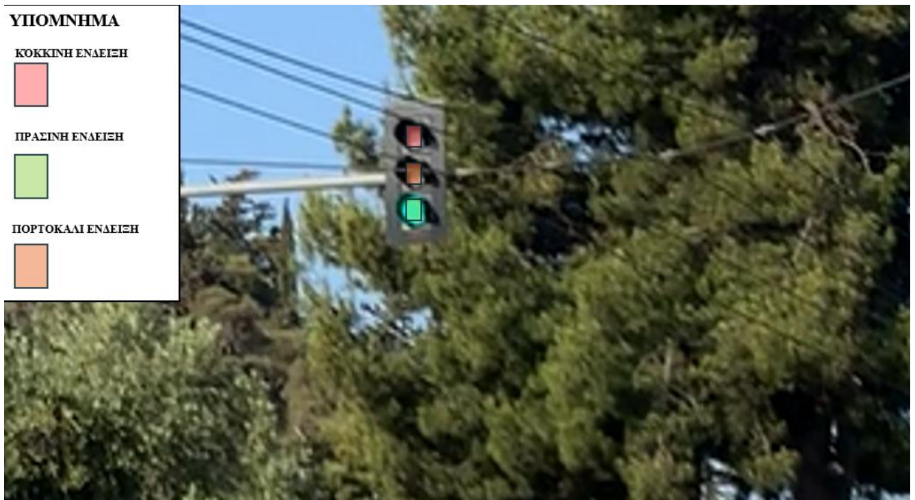
Εικόνα 4.3: Φωτεινοί Σηματοδότες Οχημάτων
