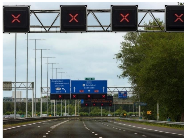
Εικόνα 2.37 Κλείσιμο λωρίδων κυκλοφορίας - ΟΛΛΑΝΔΙΑ.
