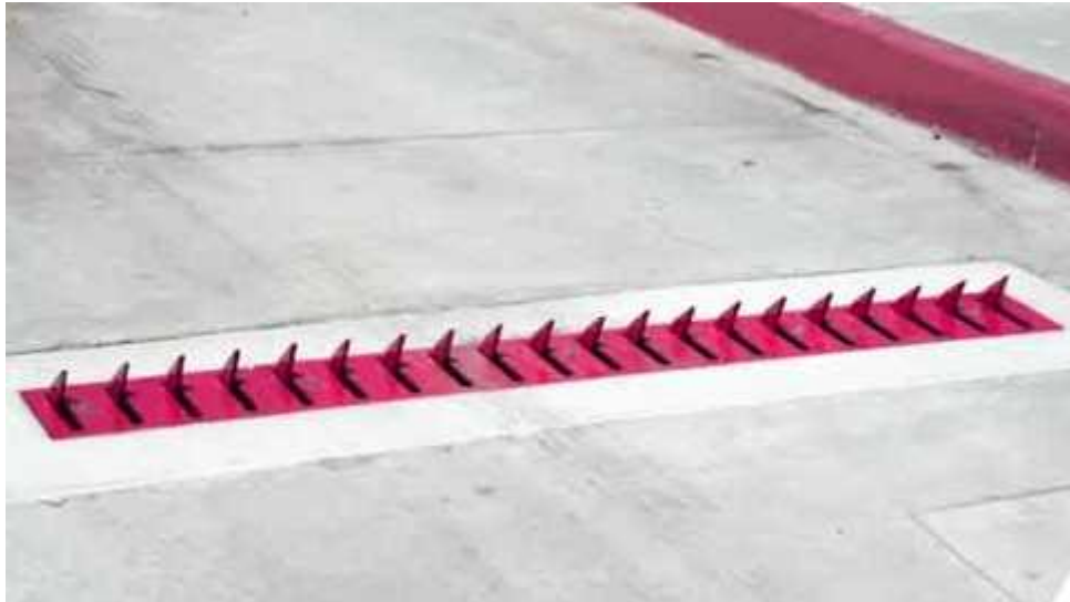
Εικόνα 2.65 Εγκατάσταση καρφιών.
