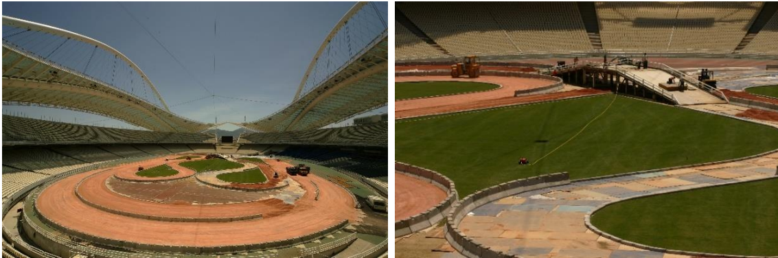
Σχήμα 8.10. Εικόνες από την κατασκευή της διαδρομής, δεξιά διακρίνεται το σανίδωμα που εφαρμόστηκε κάτω από τις στρώσεις οδοστρώσας προς προστασία του υπόβαθρου. (Πηγή: Αρχείο διεύθυνσης Ο.Α.Κ.Α.)
