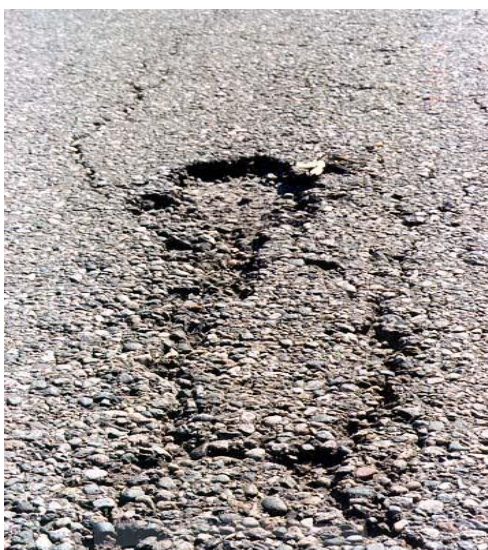
Εικόνα 2.10 Αποκόλληση αδρανών
