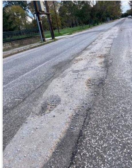
Εικόνα 2.8 Καθίζηση οδοστρώματος
