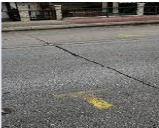
Εικόνα 2.5 Εγκάρσια ρωγμή
