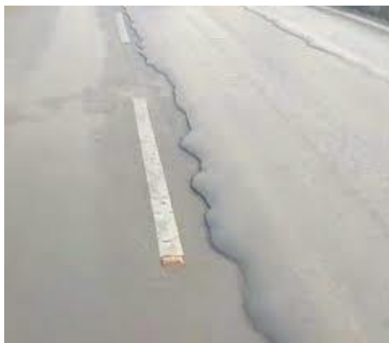
Εικόνα 2.11 Ανάδυση ασφάλτου
