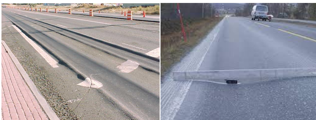
Εικόνα 2.6 Αυλακώσεις οδοστρώματων
