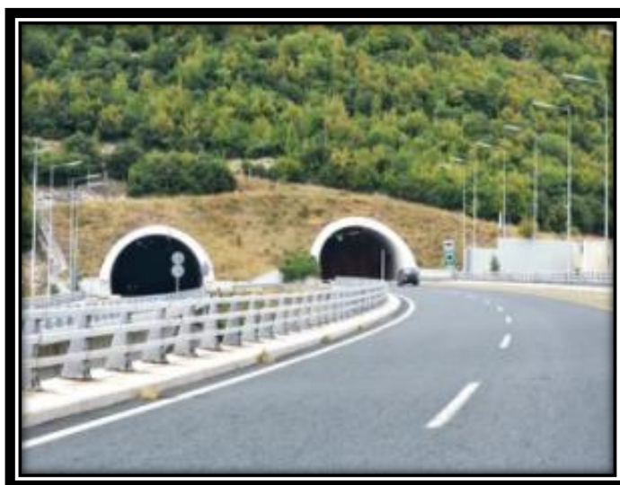
Εικόνα 3.10: Περιοχή εισόδου σε οδική σήραγγα
