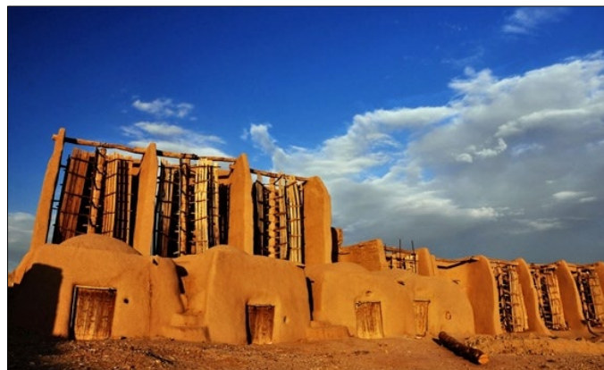
Εικόνα 2.2 : Περσικοί ανεμόμυλοι για σύνθλιψη σιτηρών και άντληση νερού (πηγή: Solaripedia)
