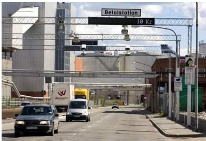
Εικόνα 4: Πύλη εισόδου στην περιοχή τιμολόγησης
