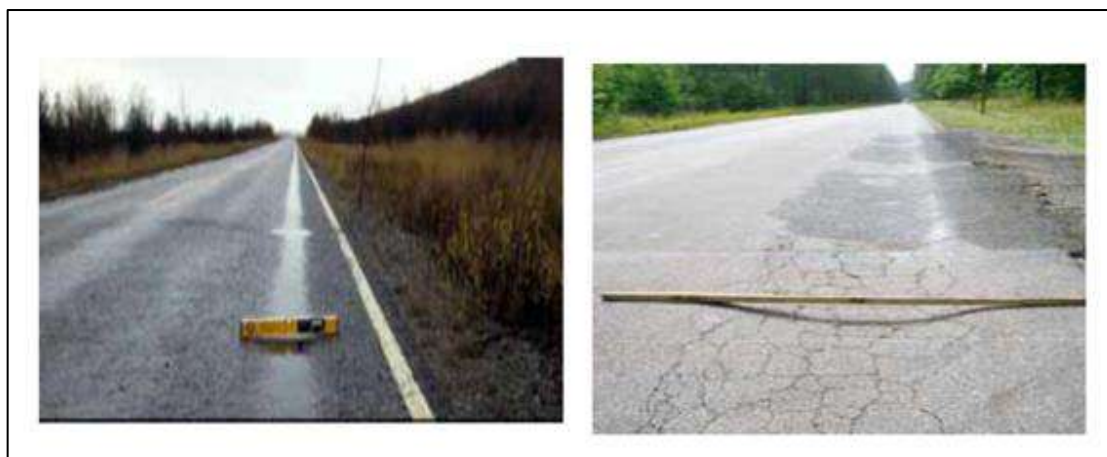
Εικόνα 3.3 Νερό που συλλέγεται σε μία τραυχαυλάκωση κατά μήκος μίας οδού και ρηγματώσεις στην ασφαλτική στρώση λόγω αστοχίας του υπεδάφους (Dawson and Kolisoja, 2004)
