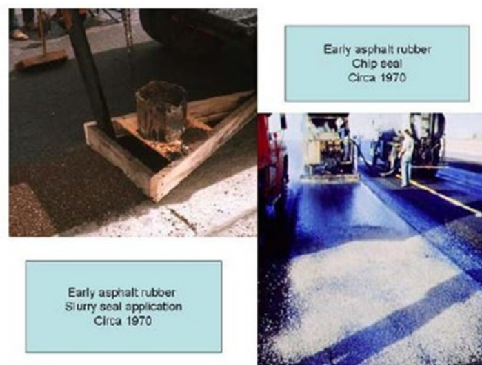
Εικόνα 3.3 Εφαρμογή στα ασφαλτομίγματα τύπου Slurry (1970)
