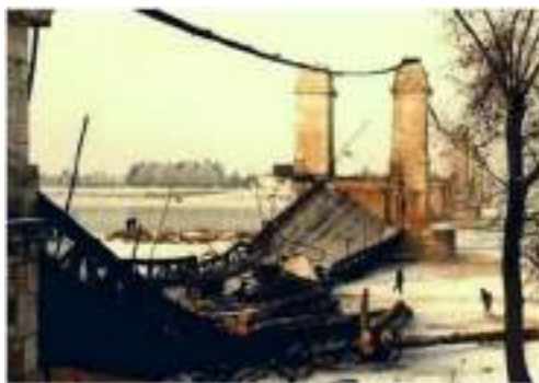
Εικόνα 1.2: (α) Φθορές στην επιφάνεια οδοστρώματος, (β) Κατεδάφιση γέφυρας λόγω υπερφορτώσης βαρέου οχήματος
