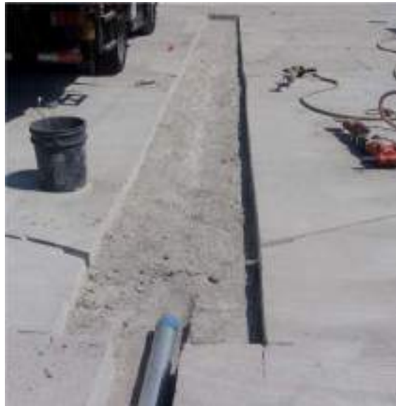
Εικόνα 1.8: Εκσκαφή του εδάφους για τοποθέτηση καμπτόμενων πλακών
