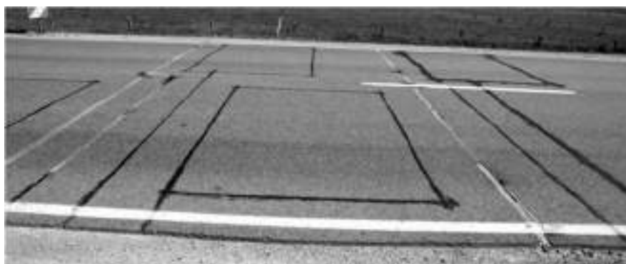
Εικόνα 1.7: Πιεζοηλεκτρικά συστήματα WIM
