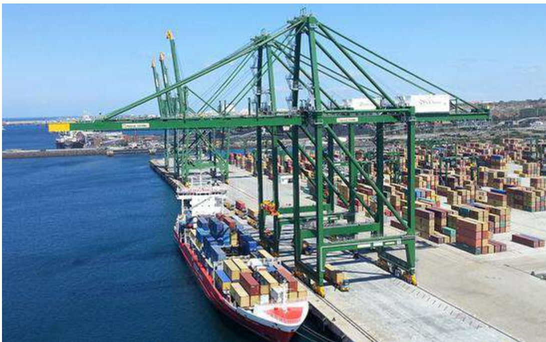
Εικόνα 19 Φορτοεκφόρτωση στο κρηπίδωμα με γερανογέφυρα 71
