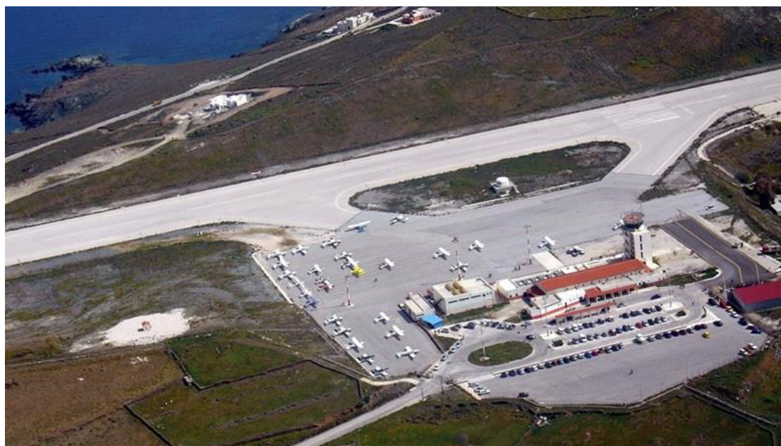
Εικόνα 15 Δάπεδα στάθμευσης Αεροδρομίου της Σύρου
