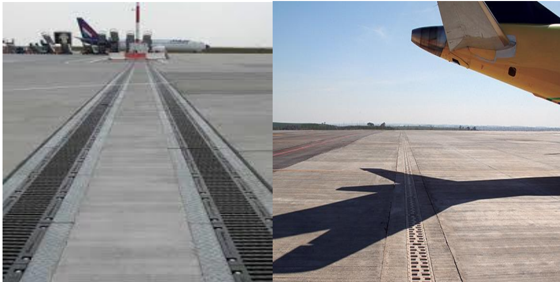
Εικόνα 36 Συστήματα Αποστράγγισης Αεροδρομίων Τμήμα Α
