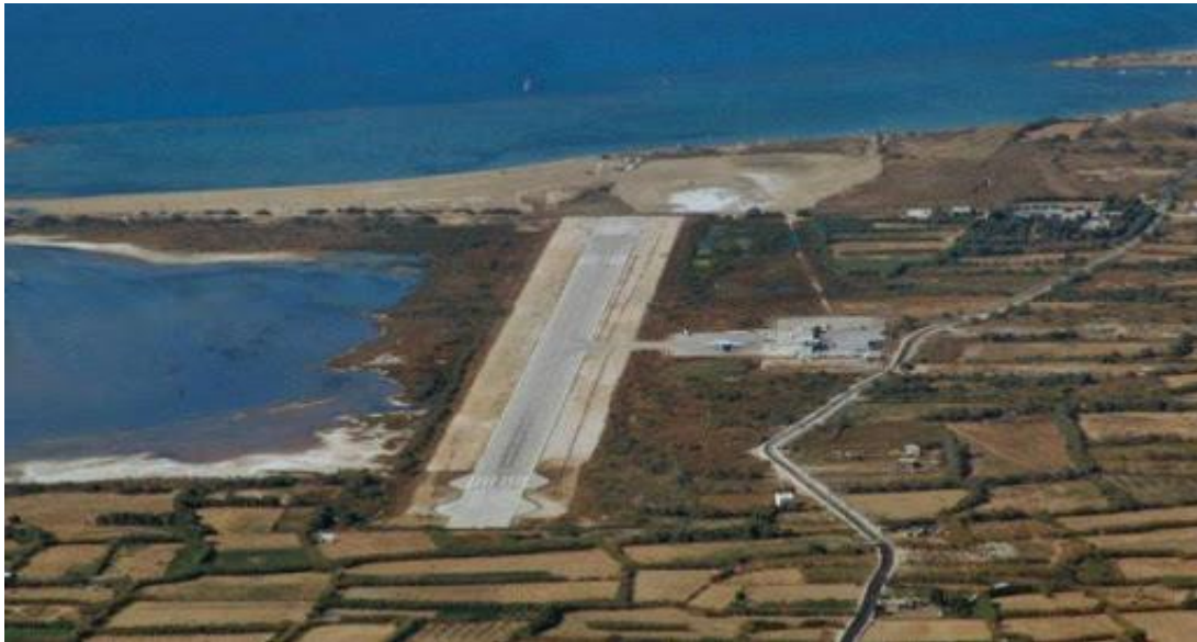
Εικόνα 29 Μέθοδος Backtrack στο αεροδρόμιο της Νάξου
