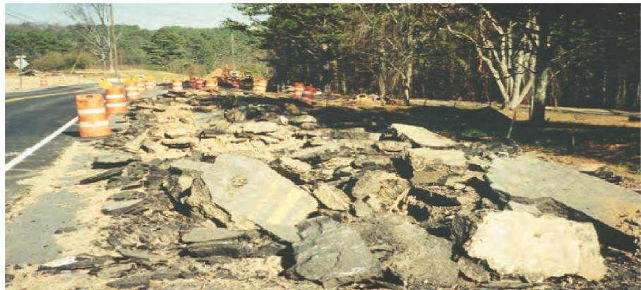
Εικόνα 3.2 Ανάκτηση πλήρους βάθους
