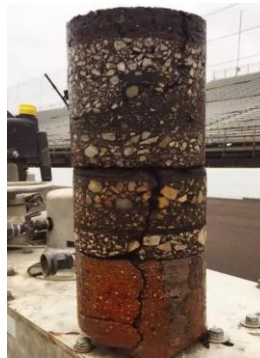
Εικόνα 2.7. Πυρηνοληψία υφιστάμενου οδοστρώματος
