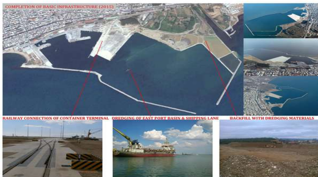
Εικόνα 40. Έργα υποδομής στον Λιμένα Αλεξανδρούπολης
