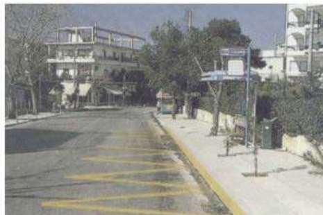
Εικόνα 3.21 - Τεθλασμένη γραμμή στο άκρο του οδοστρώματος
