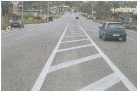
Εικόνα 3.20 - Διαγράμμιση επιφάνειας αποκλεισμού οδοστρώματος
