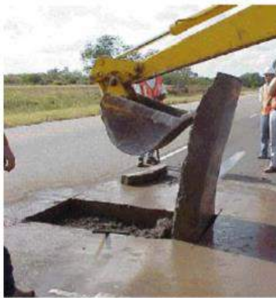
Εικόνα 2.7: Απομάκρυνση ασφαλτικού δείγματος
