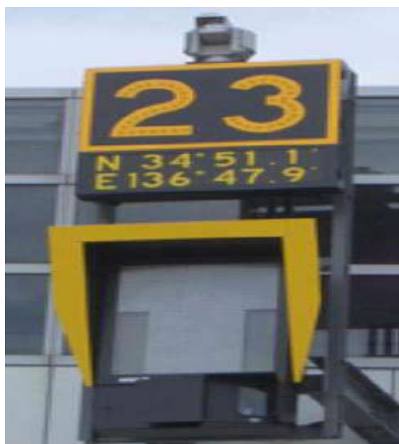
Σχήμα 3.37: Σήμα αναγνώρισης θέσης στάθμευσης
