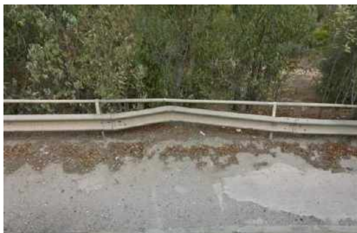
Εικόνα 4-10 Παραμορφωμένο προστατευτικό κιγκλίδωμα στην ακτίνα R=65m
