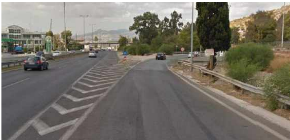
Εικόνα 4-2 Θέση μέτρησης ATC-1 όπως φαίνεται από την θέση του οδηγού
