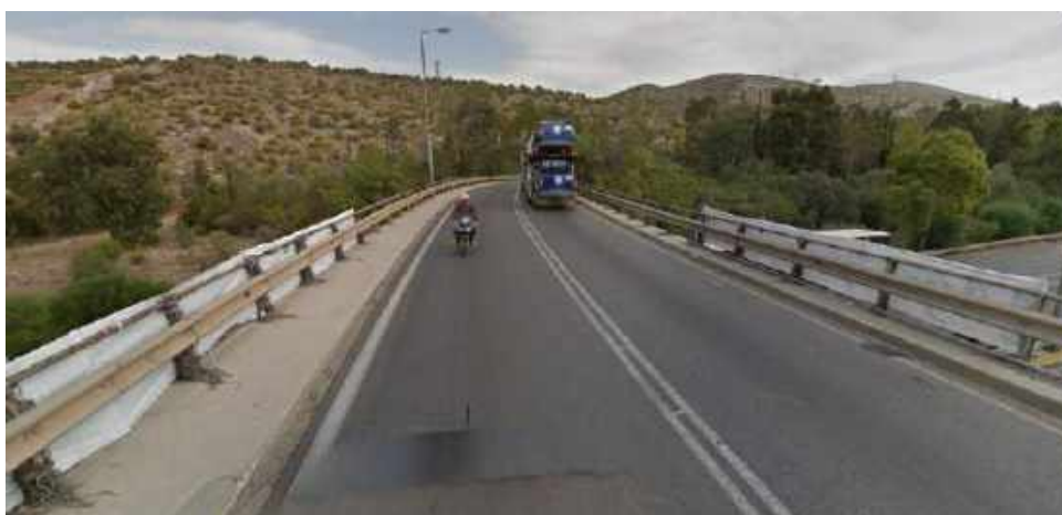
Εικόνα 4-6 Θέση μέτρησης ATC-3 προς Κόρινθο όπως φαίνεται από την θέση του οδηγού
