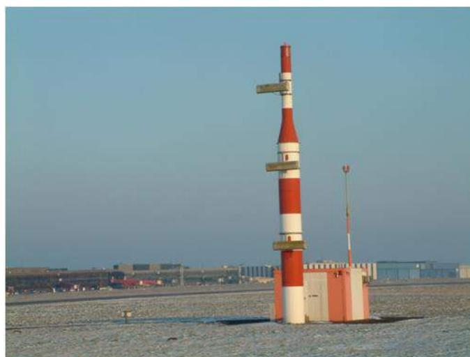
**Εικόνα 2.19:** Καθοδηγητής τροχιάς κατολίσθησης (GlideSlope) στο αεροδρόμιο του Αννόβερου στη Γερμανία (διάδρομος 09R)
