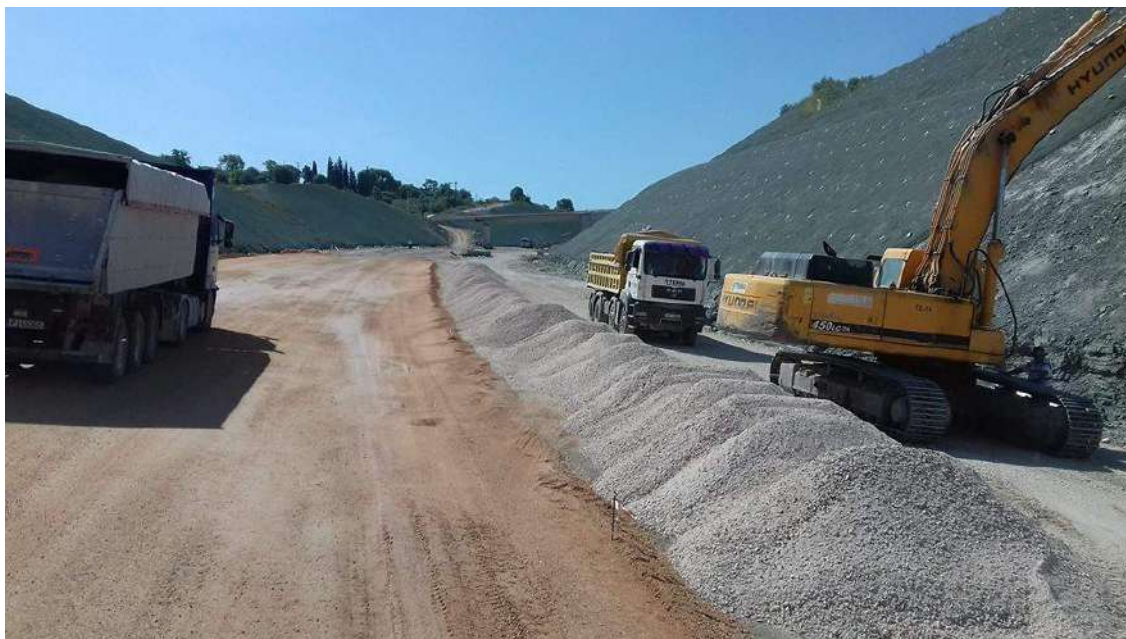
Εικόνα: Εργασίες οδοστρωσίας στην Ιονία οδό, epirus news
