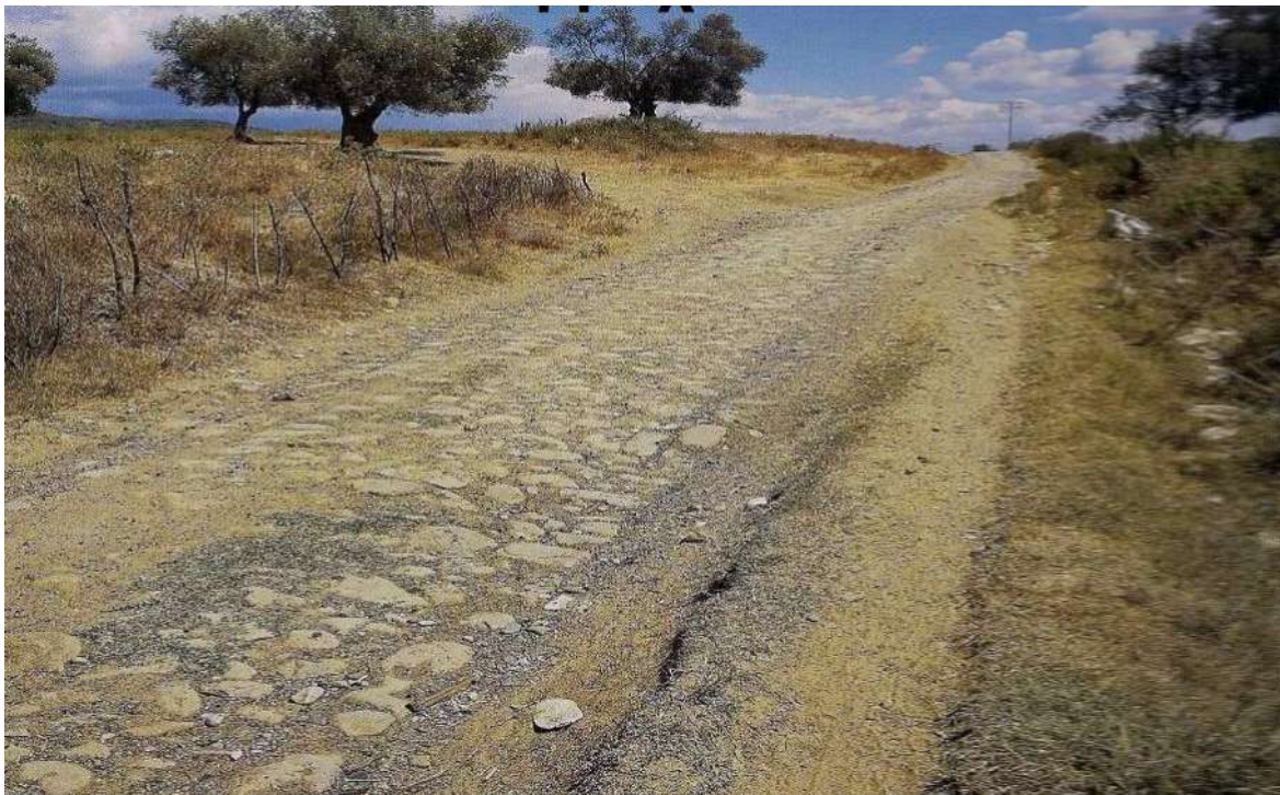
Εικόνα Τμήμα της Εγνατίας Οδού, έξω από το Δυρράχιο
