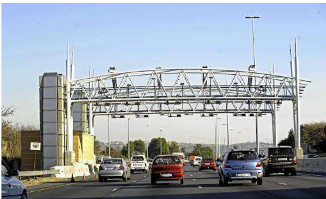
Εικόνα σταθμού διοδίων στο Gauteng, πηγή ιντερνετ
