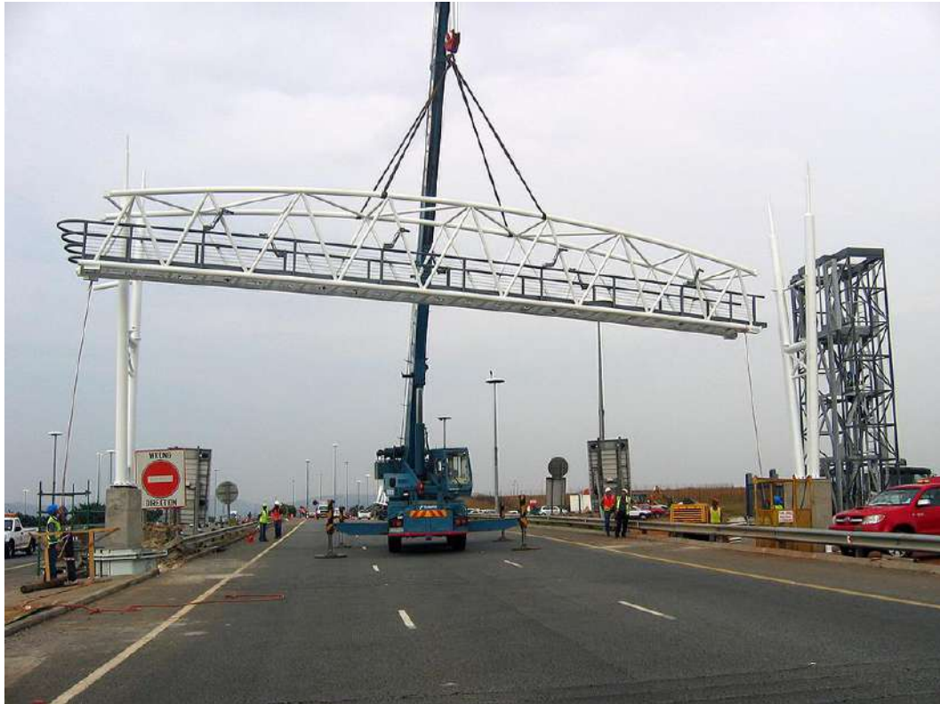
Εικόνα Κκατασκευή διοδίων στην Βόρεια Αφρική, πηγή ιντερνετ
