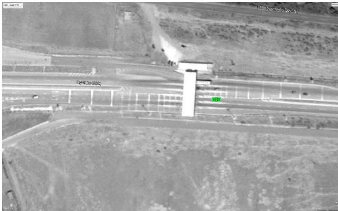
Φωτογραφία Σταθμός διοδίων Ιασμου, Google Earth Pro
