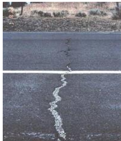
Εικόνα 4.6: Ρωγμές λόγω υπερβολικής συστολής εύκαμπτου οδοστρώματος
