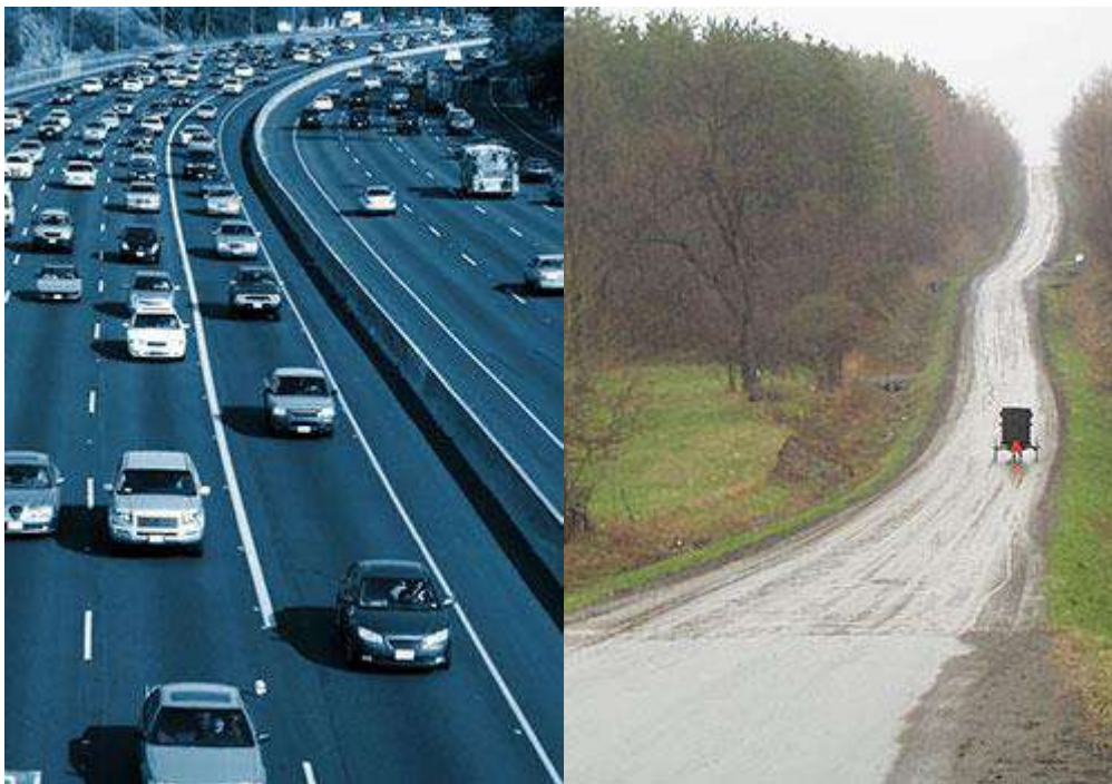
Εικόνα 2. 7 Δεξιά: οδόστρωμα χαμηλής κυκλοφορίας. Αριστερά: οδόστρωμα υψηλής κυκλοφορίας Πηγή: Cornell Local Roads Program (CLRP), 2016
