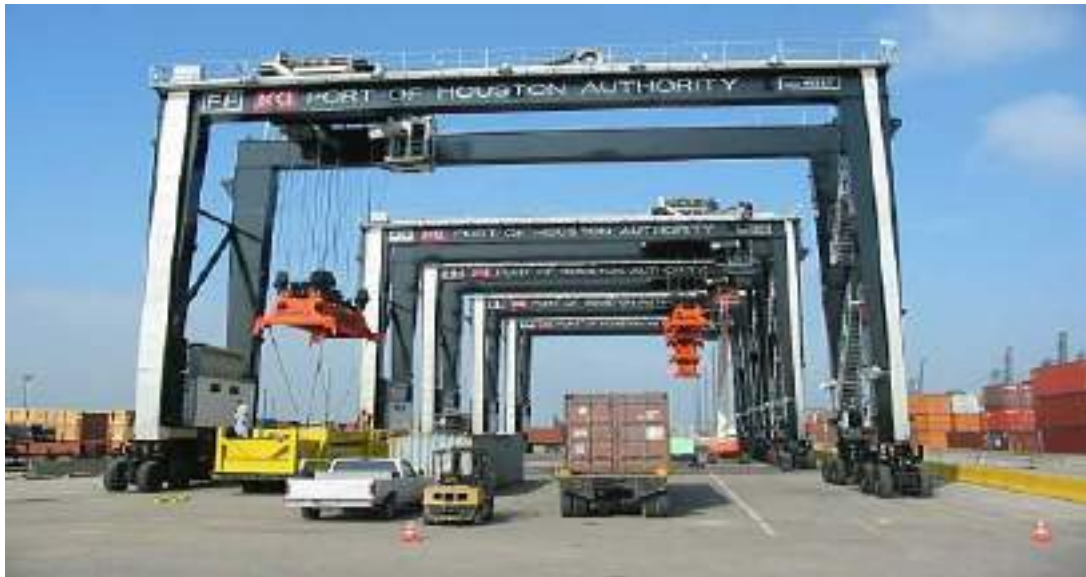
Εικόνα 13 Γερανογέφυρες επί ελαστικών τροχών [Πηγή: KoneCranes, http://www.konecranes.com ]
