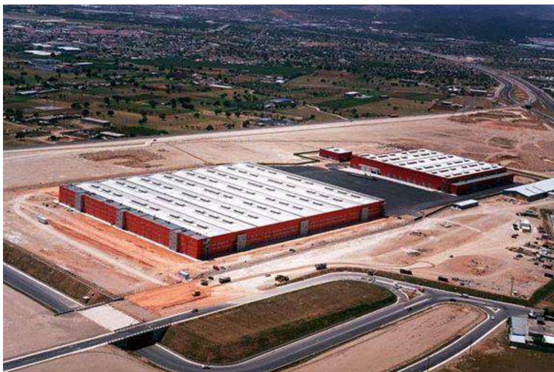
Εικόνα 34. Κτιριακές εγκαταστάσεις ΟΣΕ, Πηγή:[48]
