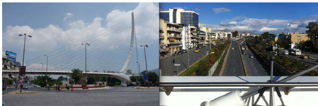
Σχήμα 1: Πεζογέφυρα Calatrava και τοποθέτηση της βιντεοκάμερας
